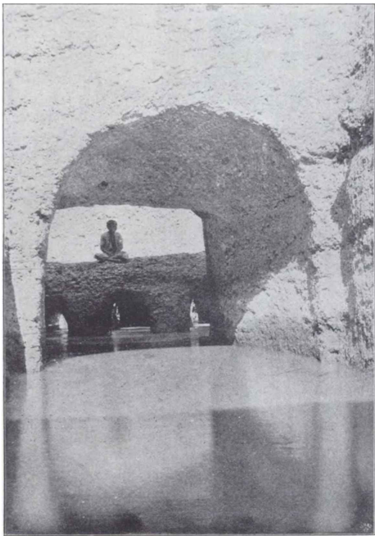
Ngûb-Tunnel zur Ableitung des Kanals nach Kalach aus dem großen Zab. (Vorn stagnierendes Wasser des Kanals, im Hintergrunde Durchblick zum großen Zab.)
